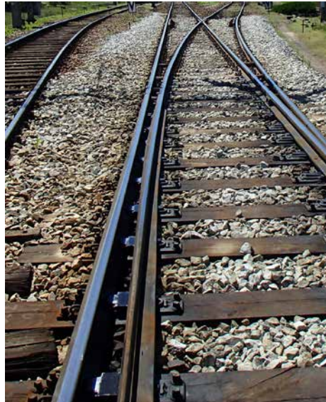
Rys. 35. Zwrotnice z iglicami szynowo-sprężystymi
