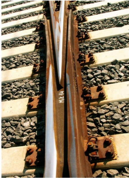
Rys. 55. Krzyżownica manganowa ze staliwa wysokomanganowego z wkładką manganową typu „Insert”, łączona z szynami skrzydłowymi za pomocą śrub sprężających
