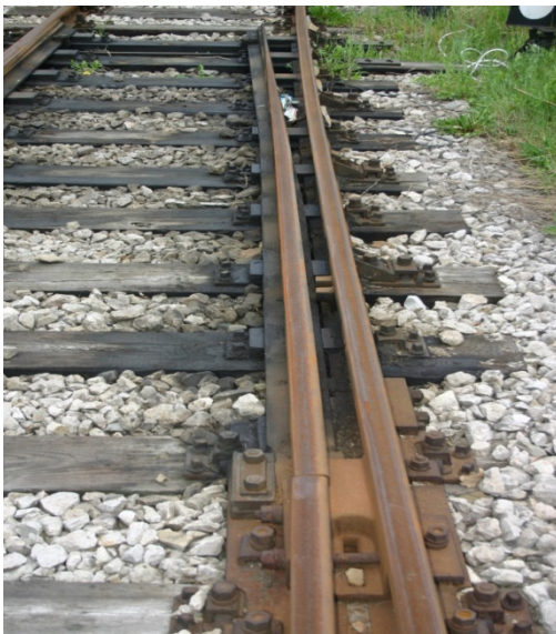
Rys. 36. Zwrotnice z iglicami czopowymi
