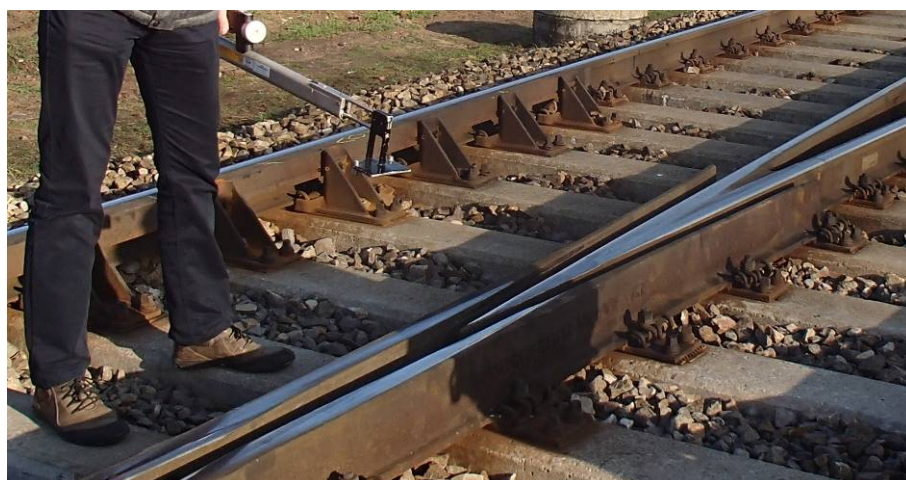
Rys. 52. Krzyżownica szynowa z dziobem z szyn zwykłych
