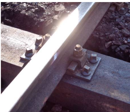
Rys. 7. Przytwierdzenie typu K, źródło: opracowanie własne
