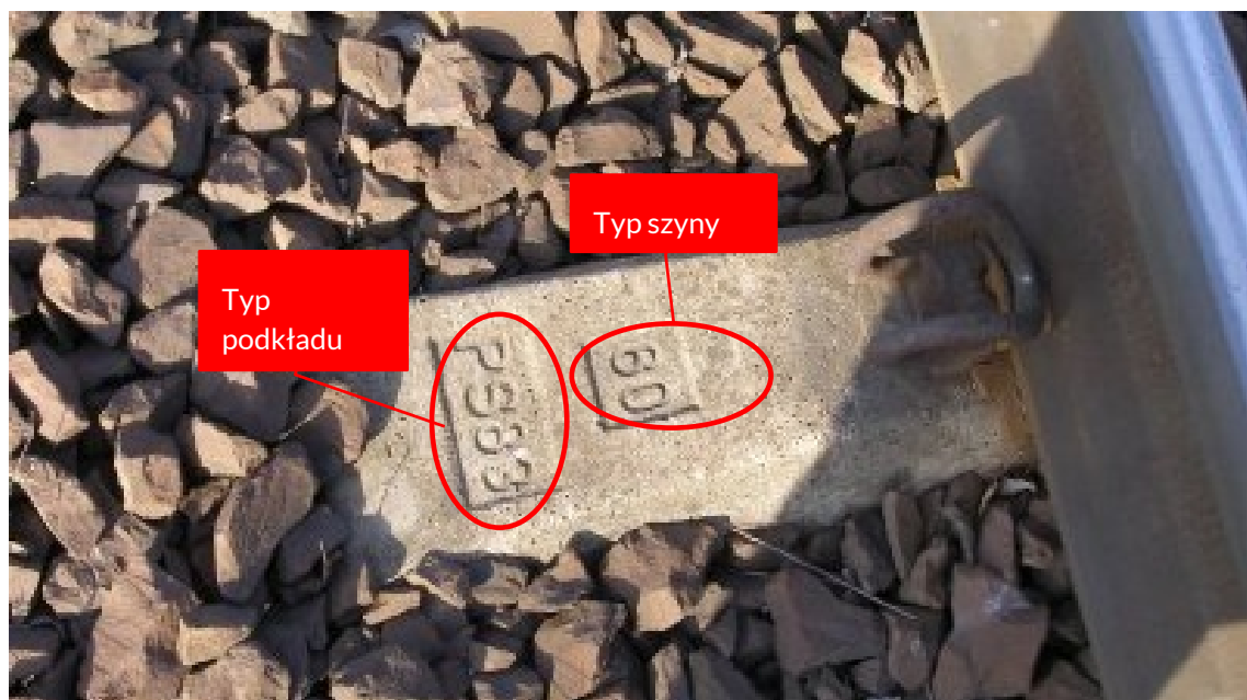
Rys. 18. Cechowanie podkładu strunobetonowego
