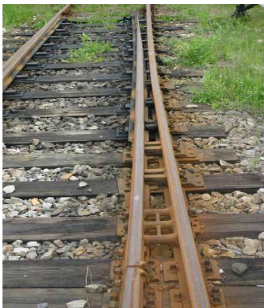
Rys. 34. Zwrotnice z iglicami sprężystymi
