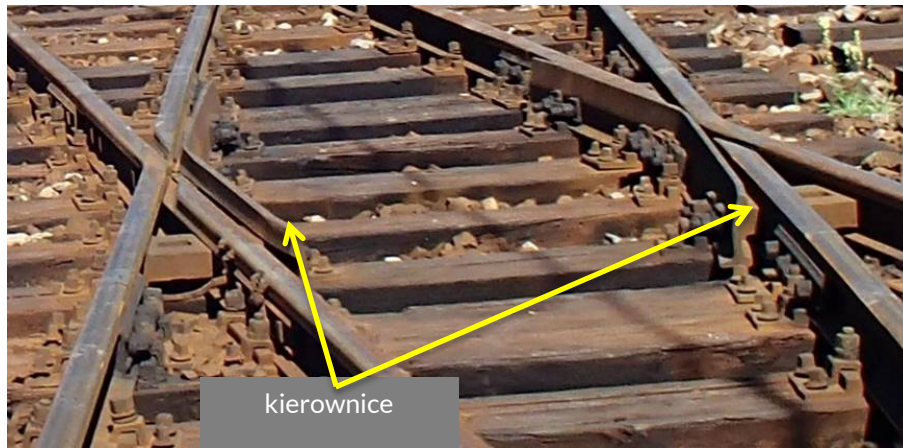
Rys. 58. Kierownice w krzyżownicy podwójnej
