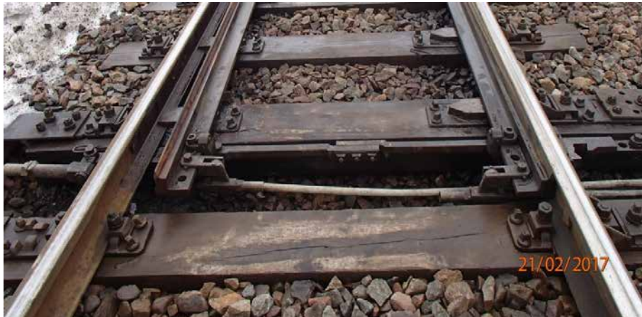
Rys. 40. Zamknięcie nastawcze suwakowe w rozjazdach zwyczajnych
