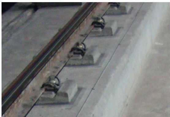
Rys. 10. Przytwierdzenie szyn do podpory blokowej
