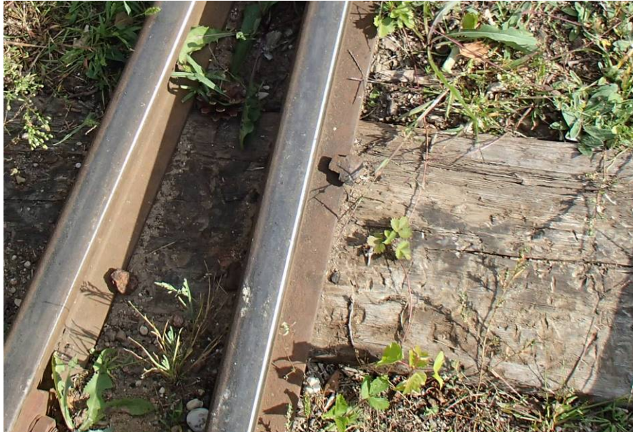
Rys. 6. Przytwierdzenie bezpośrednie szyn
