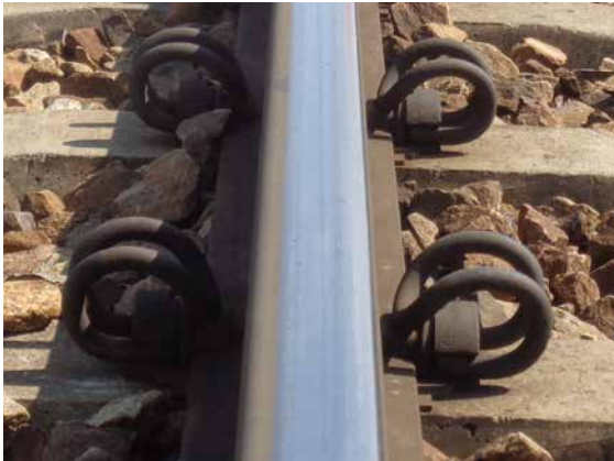
Rys. 8. Przytwierdzenie sprężyste typu SB
