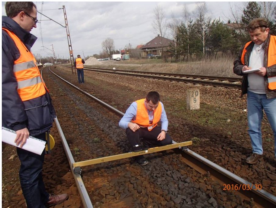
Rys. 68. Pomiar przy wykorzystaniu toromierza ręcznego
