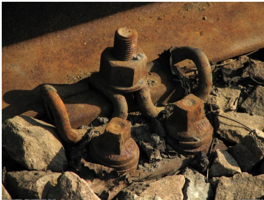
Rys. 9. Przytwierdzenie półsprężyste typu skl
