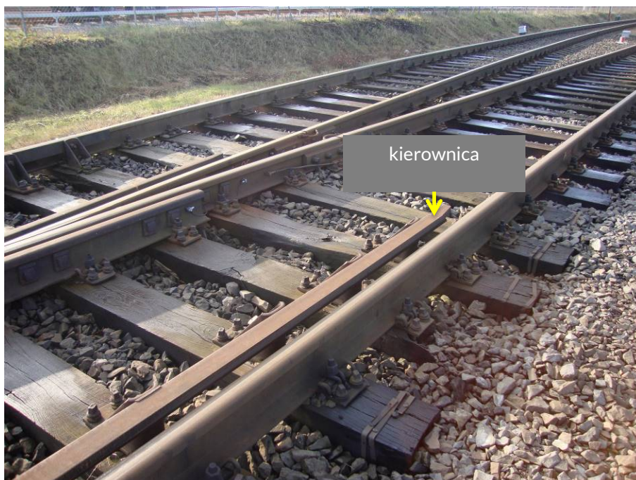
Rys. 57. Kierownica
