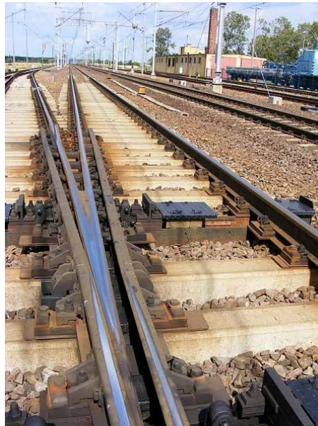
Rys. 56. Krzyżownica rozjazdu z ruchomym dziobem
