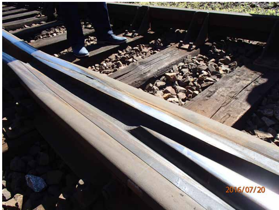
Rys. 55. Krzyżownica manganowa ze staliwa wysokomanganowego z wkładką manganową typu „Insert”, łączona z szynami skrzydłowymi za pomocą śrub sprężających
