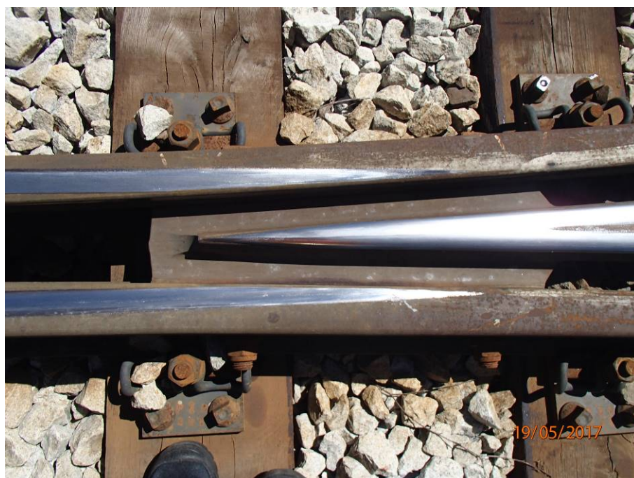
Rys. 53. Krzyżownica kuto-zgrzewana, z dziobem kutym zgrzanym oporowo z szynami dziobowymi
