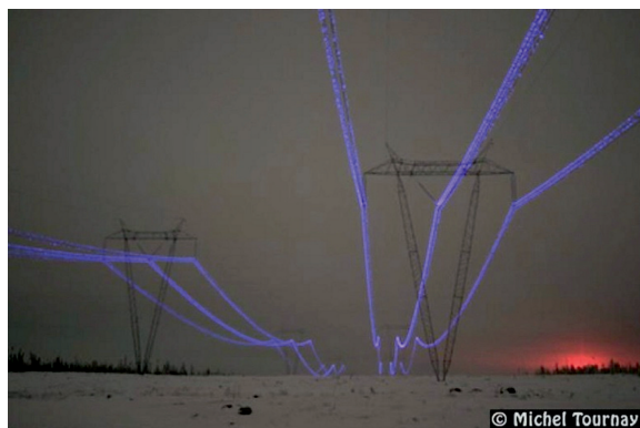
Rys. 5. Wyładowania koronowe wokół linii wysokiego napięcia
