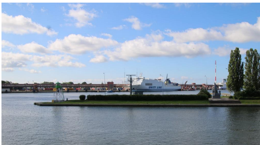
Zdjęcie 7 - Usytuowanie stacji radarowej VTS Kosa w rejonie stawy Kosa N (foto: B.Szymczyk – Google Earth).
