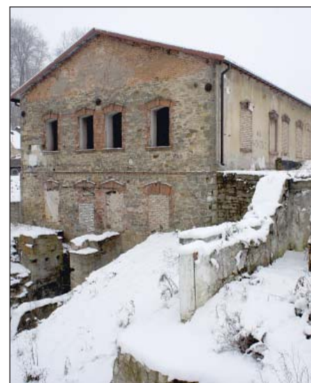
Fot. 3 Dawna hala tekturowni z turbinownią przed rozpoczęciem prac adaptacyjnych
