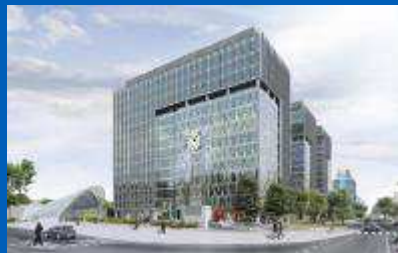
West Station | Warszawa Oddanie do użytku: IV kwartał 2016 r. 30 400 m kw. GLA Wycena ukończonego projektu: 77,4 mln EUR
